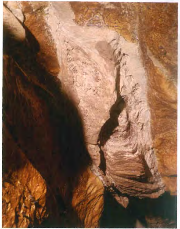
Abb. 4: Paläokarstfüllung mit deutlicher Schichtung, die nachträglich durch Setzungen nach unten verbogen wurde.
